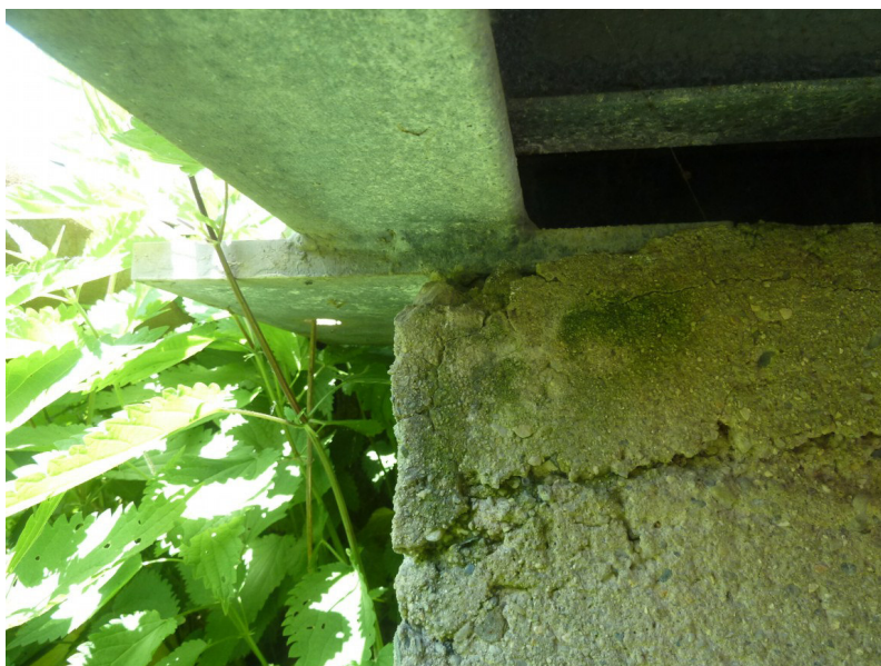
Detail uložení NK na vtoku na pravé opěře, ložisko z 1/2 uloženo mimo opěru
