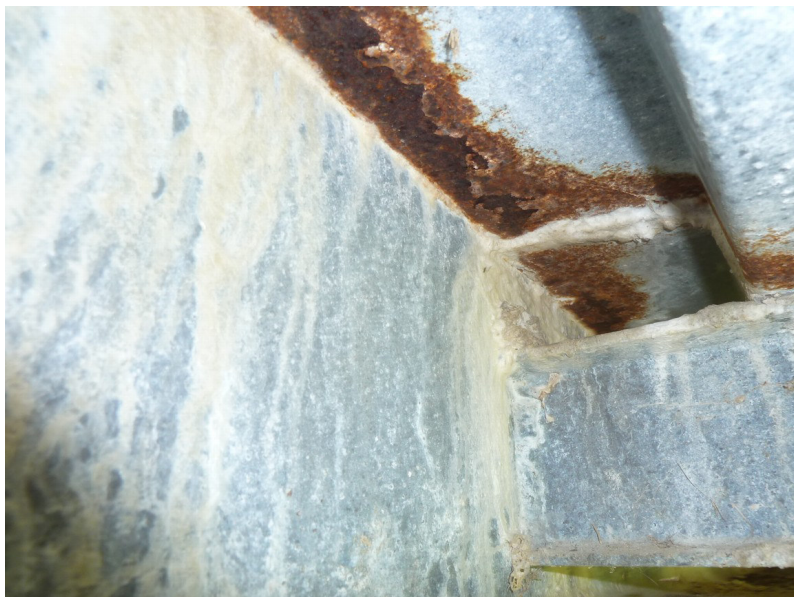
Detail kraje podhledu nosné konstrukce, stopy po zatékání, koroze
