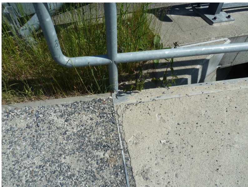
Detail přechodu mostovky a chodníku
