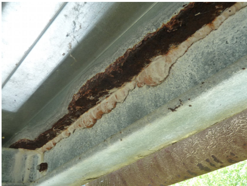
Detail podhledu NK, stopy po zatékání, koroze
